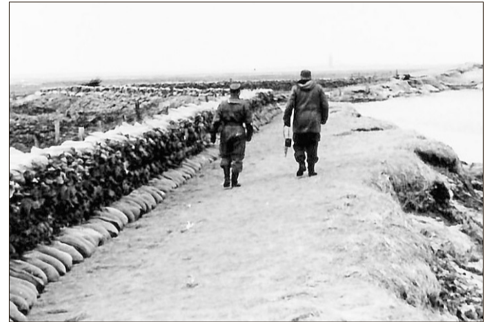
Aus Sandsäcken wurde die Lücke im Dorfdeich provisorisch geschlossen.
