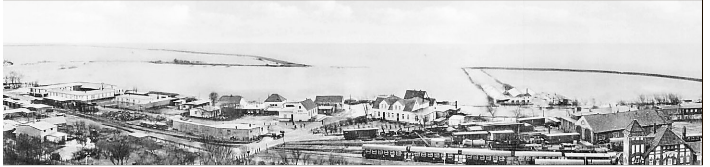
Blick vom Leuchtturm: Der Deich wurde auf etwa 300 Meter Länge weggespült, das Wasser überflutete den Dorfgroden.
