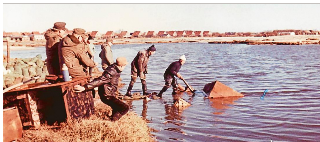
Die Sturmflut ließ einen tiefen Kolk entstehen. Hinter den Häusern an der Siedlerstraße stand das Wasser. Links ein Stück des Sandsackdeiches.
