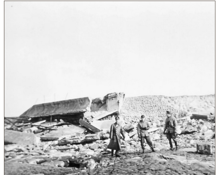
Die Westufermauer wurde von den Brechern der Sturmflut regelrecht zerschmettert.
